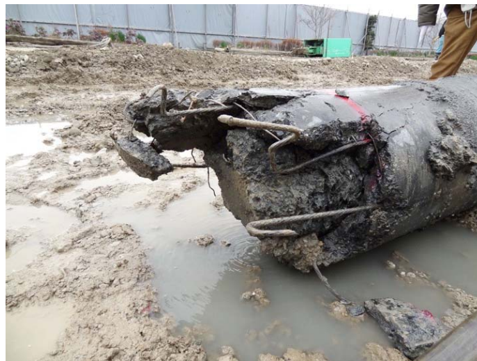
写真 4.16 新校舎の引き抜かれた杭先端部（撮影：三辻和弥博士）
