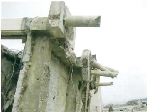
写真-2 前面側基礎の杭5本の状況 (2011.5.20撮影)
