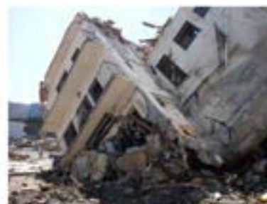
写真4 隣で転倒した建物
