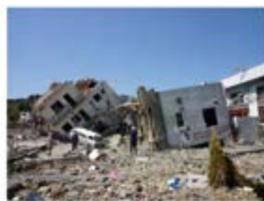
写真1 女川交番 (右側建物、左側はRC造集合住宅（反対向きに転倒）)
