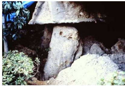
写真-4 杭頭の状況
