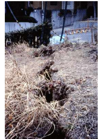
写真-7 地割れの詳細
