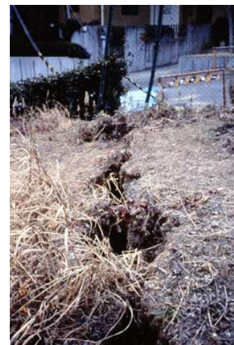
写真-7 地割れの詳細
