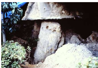
写真-4 杭頭の状況
