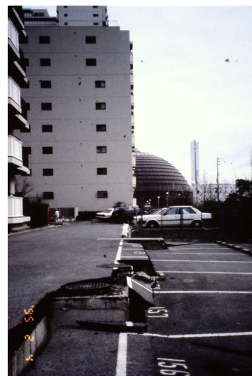
写真-8 段差の例
